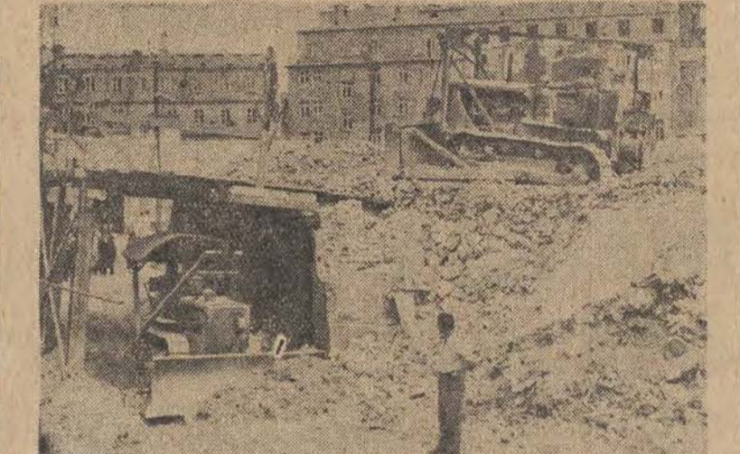
Zmechanizowane odgruzowanie terenu przy ul. Marszałkowskiej. Wielki spychacz radzieckiej produkcji „Staliniec”, w ciągu dnia pracy usuwa od 600 do 700 m sześć. gruzu w promieniu 50 m.
