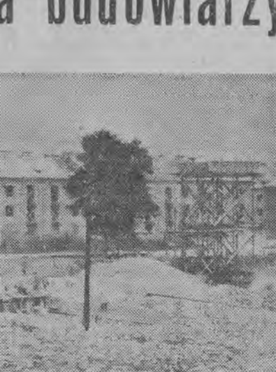
KRAKÓW (PAP). — Z Nowej Huty napływają w dalszym ciągu meldunki o długofalowych zobowiązaniach, jakie podejmują wszystkie załogi przedsiębiorstw budowlanych w celu przedterminowego zrealizowania
