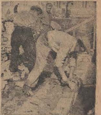
Dnia 15 bm. zespoły ZMP przystąpiły do budowy Domu Towarowego na Mariensztacie. Budowę prowadzą całkowicie ZMP-owcy. Na zdj.: 20-letni murarz Edward Skibiński przy układaniu fundamentów.
