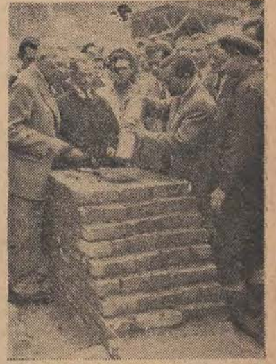
Dnia 16 bm. nastąpiło uroczyste wmurowanie aktu erekcyjnego pod budowę Marszałkowskiej Dzielnicy Mieszkalowej. Na zdj.: przewodniczący Stołecznej Rady Narodowej J. Albrecht wkłada akt erekcyjny w fundamenty bloku 6-B MDM.
