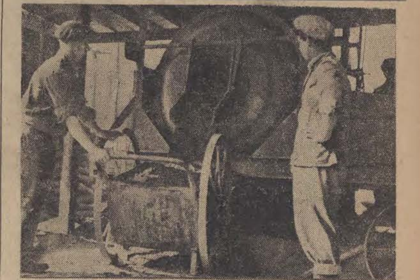
Budowa Marszałkowskiej Dzielnicy Mieszkaniowej postępuje szybko naprzód. Na budowie ruszyły nowoczesne betoniarki, sprowadzone z NRD. Przy betoniarce pracują: Żurawski Tadeusz i Powiański Zdzisław.
