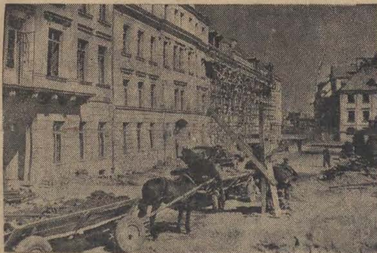
Tempo robót w Warszawie wzrasta. Stolica z dnia na dzień staje się ładniejsza. Na zdjęciu — fragment ulicy Senatorskiej w odbudowie.
