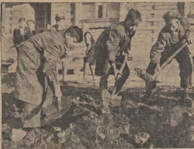
Młodzież Stolicy bierze aktywny udział w odbudowie Warszawy. Na zdjęciu — grupa uczniów z Państwowego Gimnazjum Elektrycznego przy odgruzowaniu Muranowa.
