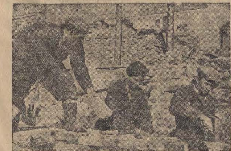
Budowa nowej Dzielnicy Mieszkaniowej przy ulicy Marszałkowskiej (MDM) postępuje szybko naprzód.
