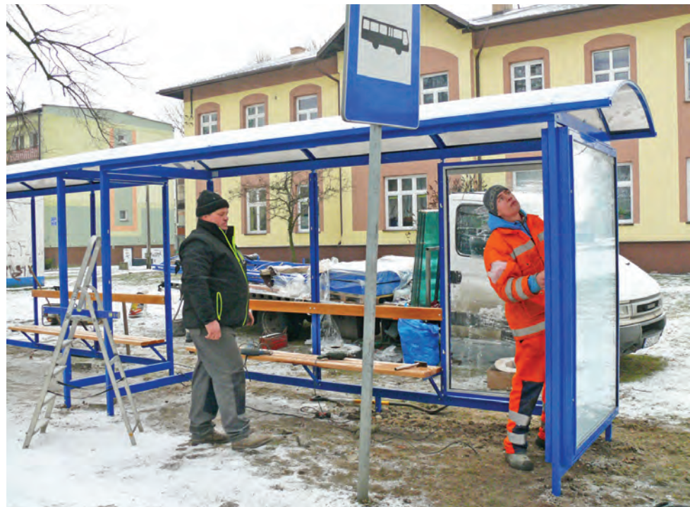
Montaż wiat autobusowych na przystanku przy ul. Armii Krajowej w sąsiedztwie osiedla bloków komunalnych.
