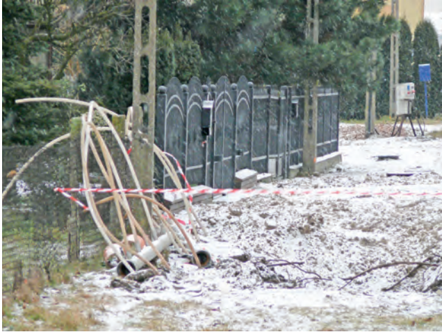
Pracownicy ZUK wykonują obecnie sieć kanalizacyjną wzdłuż ulicy Kaliskiej, układając ją w pasie pomiędzy ogrodzeniami posesji a jezdnią.
