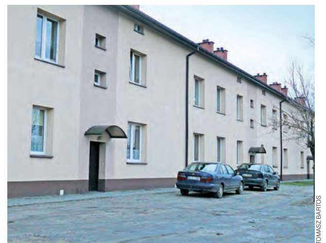
Blok nr 3 przy ul. Szkolnej w Bełchowie – jeden z dwóch, których mieszkańcy będą mogli wykupić zajmowane mieszkania lokatorskie.
