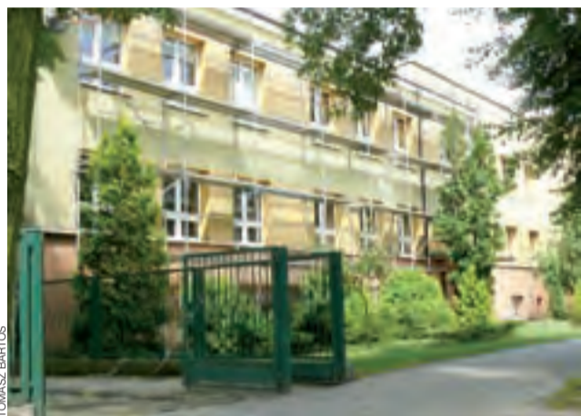
Trwa wymiana obróbek blacharskich na budynku SP1 w Łowiczu.
