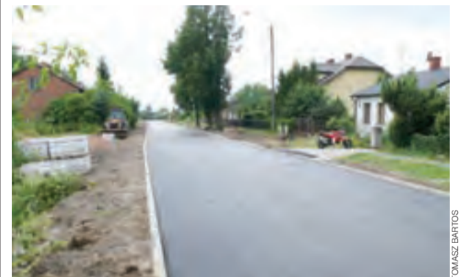
Walce PRID z Łowicza zagradzające wjazd na świeżo położony asfalt na ul. Kopernika.
