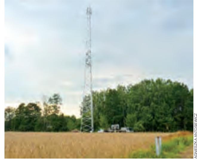
W sobotę ustawiony został maszt sieci komórkowej Play w Zielkowicach, którego nie chcą w tym miejscu mieszkańcy.
