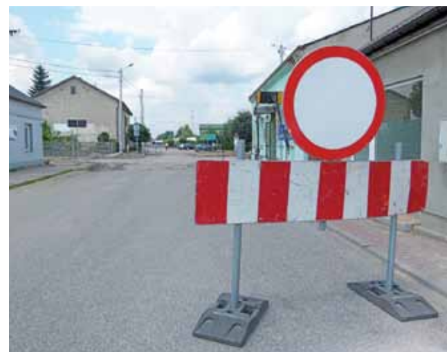
Znak i barierka zabraniająca przejazdu przez przebudowywaną 703-kę od strony ulicy Parzew w Bielawach. Foto archiwalne.
