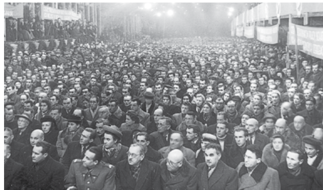
Warszawa, grudzień 1948. Wic robotników budujących Trasę W-Z.
