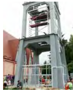
Dzwonnica przy parafii w Bobrownikach w trakcie zakładania obudowy z siatki, która zamknie dostęp do jej środka.
