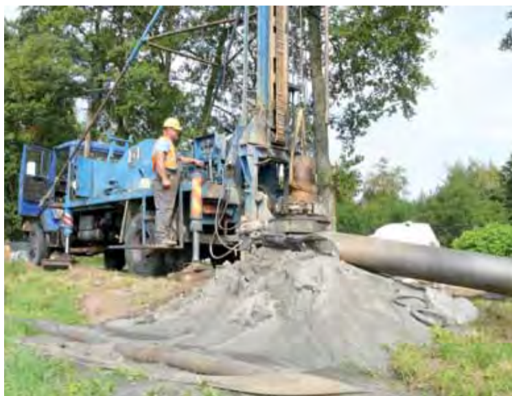
Wiercenie studni depresyjnej na ulicy Czajki sprawiło, że ulica ta stała się nieprzejezdna.
