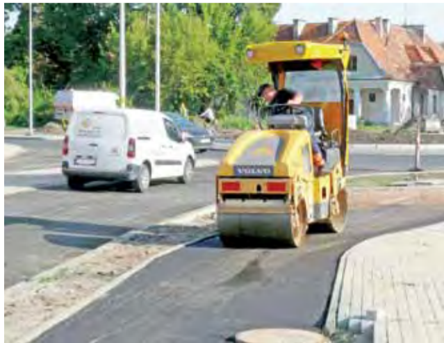
Prace prowadzone całkiem niedawno na ul. Dmowskiego – układanie masy asfaltowej na ścieżce rowerowej.
