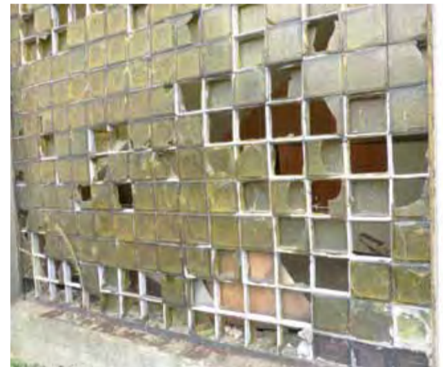
Tak z bliska wyglądają szklane luksfery, znajdujące się w szczycie budynku.
