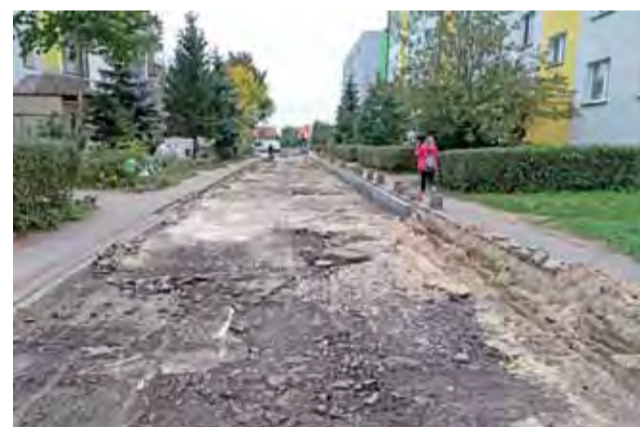
Podczas prowadzenia robót dojazd do bloków jest niemożliwy.
