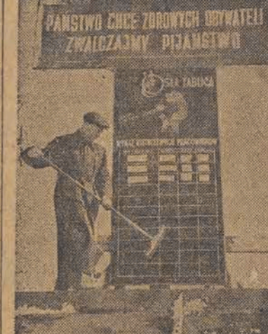
Przy wejściu na liczne budowy PPS w Warszawie obok tablic ilustrujących, najlepsze osiągnięcia we współzawodnictwie, umieszczone są tablice z wykazem pracowników za niedbujących pracę z powodu pijaństwa. O ile przez zawsze zapewniona będzie współzawodnictwa przewija się coraz więcej nazwisk to wykazy na „oślich tablicach” zmniejszają się stale. Na zdjęciu, jedna z tak zwanych „oślich tablic”. (Fot. Nowosielski)
