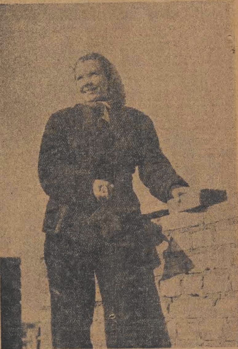
Jadwiga Leśkiewicz ze Zgierza — bydgodzińska Państw. Przeds. Budowlanego — zobowiązała się wraz ze swoją brygadą wykonywać w czasie od 1 kwietnia do 1 października rb. — 130 procent normy. Ob. Leśkiewicz wyzwa wszystkich pracowników budowlanych do pójsicia w jej ślady.
