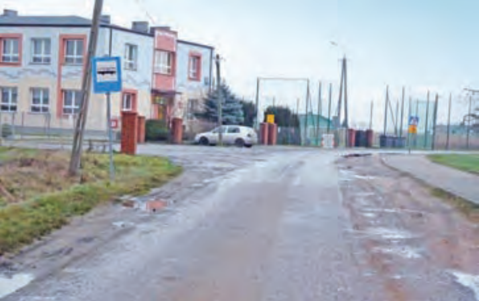
Starostwo Powiatowe w Gostyninie w 2018 roku zaplanowało kompleksową modernizację drogi od skrzyżowania koło kościoła w Pacynie aż za szkołę. Droga ma być poszerzona, zrobione odwodnienie, chodniki i zatoka autobusowa.
