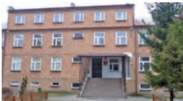
Budynek Szkoły Podstawowej w Szczycie całkowicie zmieni swój wygląd, pod warunkiem, że wniosek ZGRK zostanie zaakceptowany.
