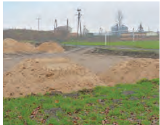
Ruszyła budowa boiska wielofunkcyjnego przy SP w Oporowie.
