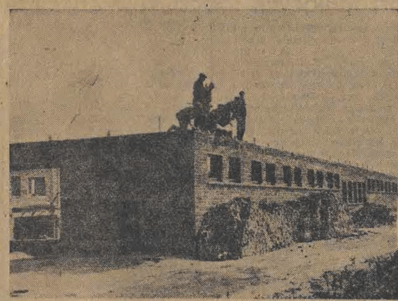
Budowa obory zespolowej w spółdzielni produkcyjnej w Wadawiu powiatu piatrkowskiego
