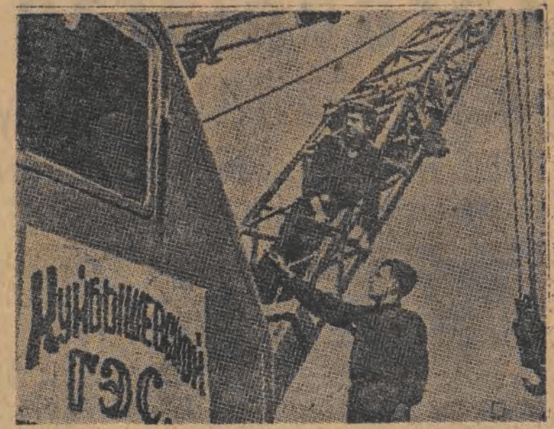
Tysiące fabryk radzieckich rozpoczęło już wysyłkę maszyn i urządzeń dla wielkich elektrowni wodnych na Woldze. Na zdjęciu: Ślusarze Zakładów Metalurgicznych im. Powstańca Styczniowego w Odessie — Demczenko i Powroźnik dokonują ostatniego przeglądu gotowych do transportu automatycznych dźwigów — dla Kujbyszewskiej Elektrowni
