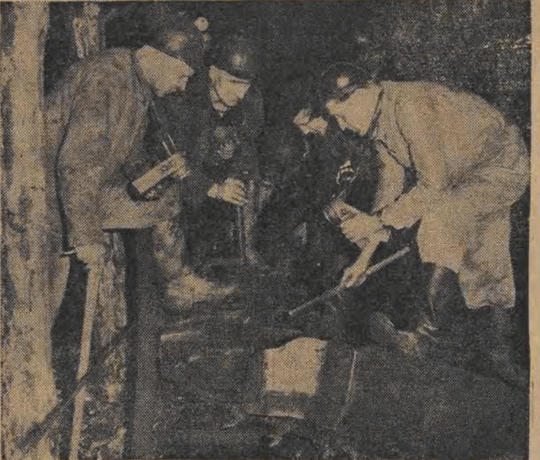
Jedną z nowych, stosowanych w górnictwie maszyn jest tzw. panczer kombinowany z wrębioladowczą. Wrębioladowaczka wrzuca ostrza lony węgla na panczer, który odprowadza go ze ściany do taśmy transportowej. W kopalni „Wieczorek” wicedyrektor, b. górnik — Wiktor Zieliński i mechanizator kopalni — Maksymilian Synacek, zjeżdżają często na dół, by sprawdzić działanie maszyn i omówić z górnikami możliwość ich jak najlepszego zastosowania i usprawnienia. Na zdjęciu: przy panczerze kombinowanym od lewej: dyr. Zieliński, mechanik Józef Piszczak, mechanizator Maksymilian Synacek i sztygar maszynowy dołu Ignacy Szyszka. Foto — AR Nowosielski
