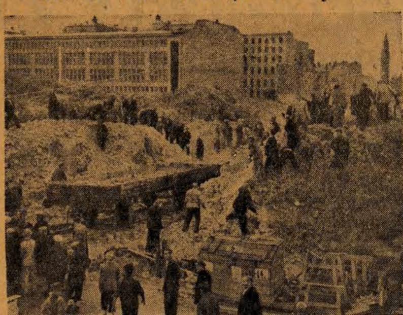
W dniu 1 września rb. Warszawa przystąpiła do budowy nowej wielkiej Trasy N-S, (północ-południe). Na zdjęciu: pierwsze ochotnicze brzozy — złożone z pracowników Stołecznych Zakładów Pracy — pomagają przy wykopach pod przyszłą magistralę. (Foto AR)
