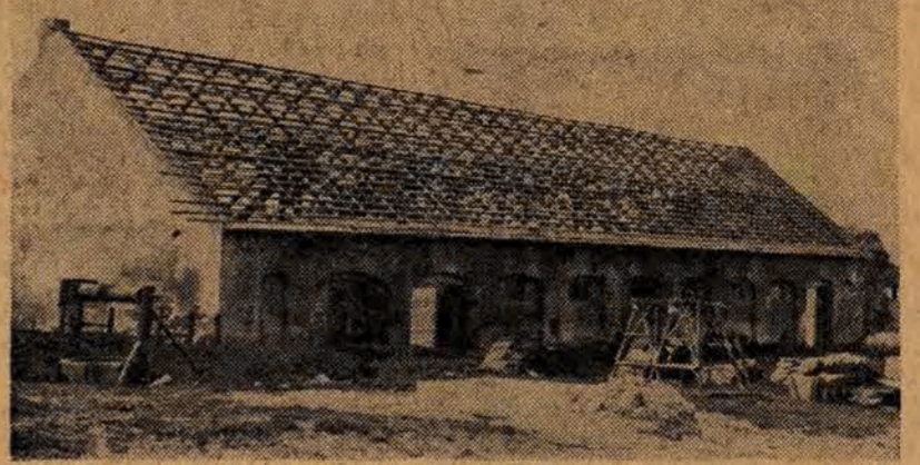
Remont obory zespołowej w spółdzielni produkcyjnej w Studziankach powiatu rawsko-mazowieckiego.
