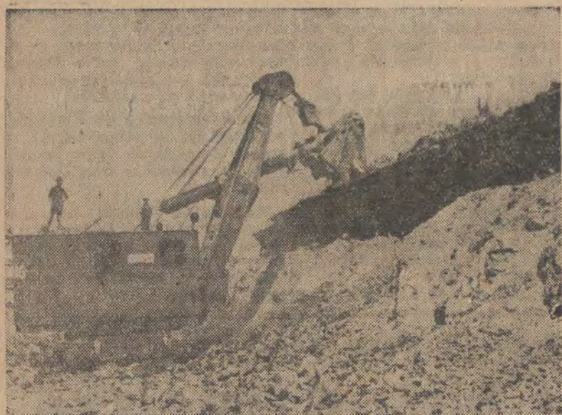
Coraz gęstsza sieć pokrywają nasz kraj linie komunikacyjne — koleje i szosy. Na zdjęciu: budowa kolei Kielce — Busko. Olbrzymie kopaczki syją ziemię z wykopów do wagoników kolejki.
