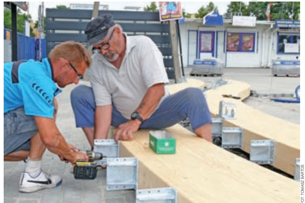
Na każdym z drewnianych dźwigarów montowanych jest ponad 30 okuć do których przykręcone zostaną tzw. płatwy, które będą wzdłużnie spinać konstrukcję.
