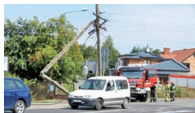
Złamany słup tuż przy ruchliwym skrzyżowaniu.
