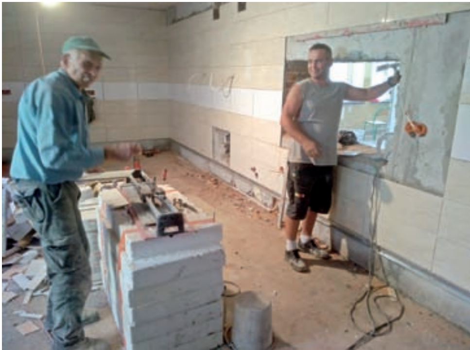
Prace przy przebudowie kuchni w budynku szkoły na Korabce mają zostać zakończone w sierpniu, później kuchnię trzeba wyposażyć.
