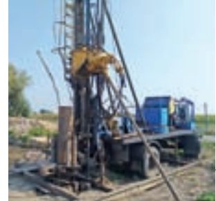
Budowa studni w Oszkowicach. Stan na 28 sierpnia.
