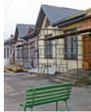
Prace przy wymianie pokrycia dachu na Domu Ludowym w Wiskienicy Dolnej - stan z połowy miesiąca.
