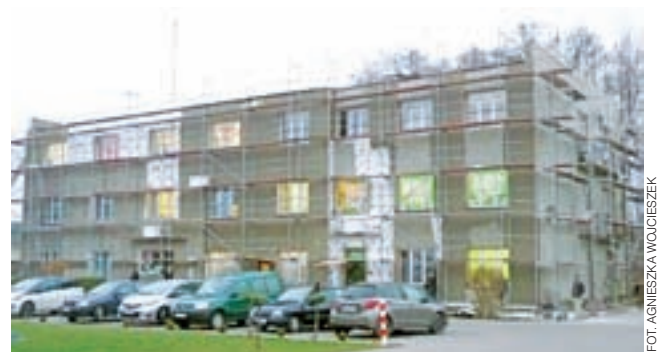
Efekty prac już są widoczne.
