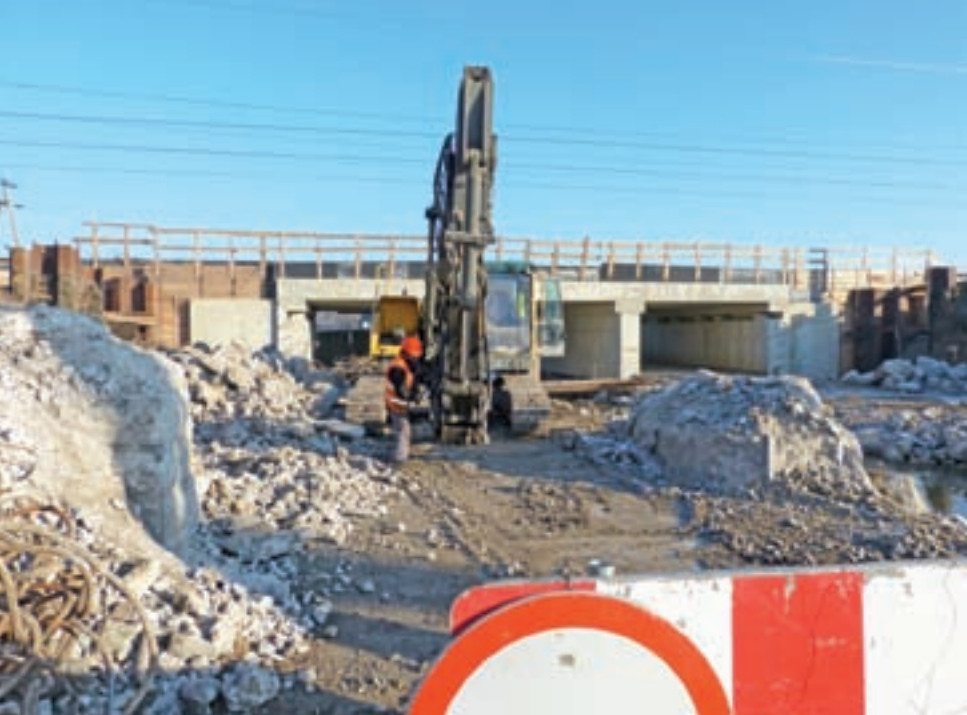
Część mostu od strony dawnej „Paszarni” została już prawie w całości wyburzona.
