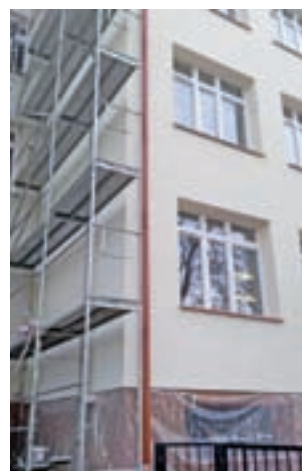
We wtorek, 17 grudnia, część rusztowań już została zdemontowana.
