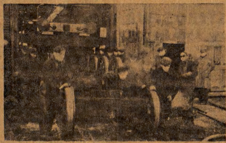
Jedną z pierwszych i najtrudniejszych czynności — wytaczanie zestawu kołowego — odbywa się szybko i sprawnie.
