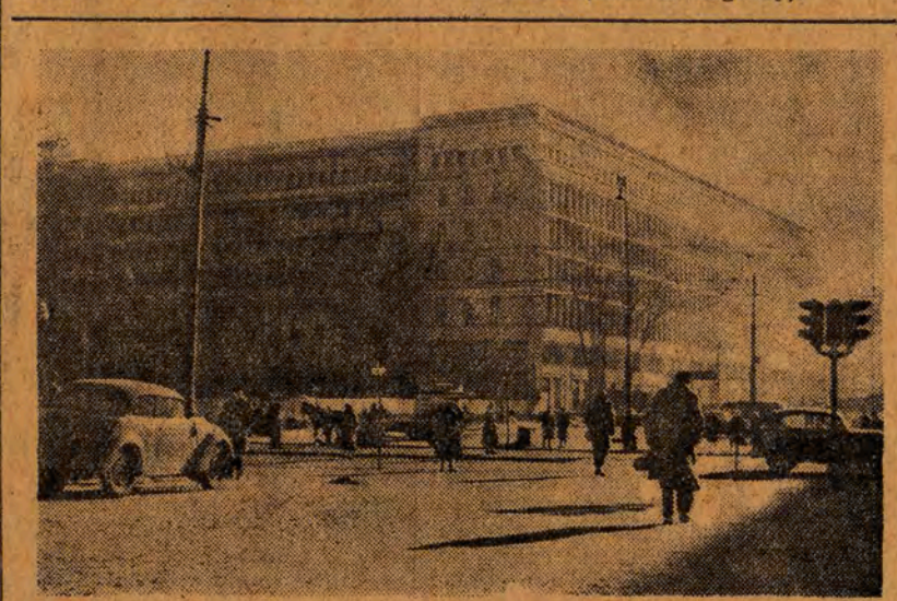
Budowa Domu Partyjnego w Warszawie — siedziby KC PZPR — postępuje szybko naprzód. Został już całkowicie wykończony front, wzdłuż ul. Nowy Świat. Obecnie trwają prace przy okładaniu białym wiankowcem fasady wzdłuż Al. Sikorskiego.
