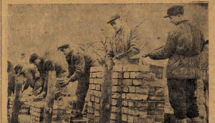
Na budowie Domu Młodzieży.
