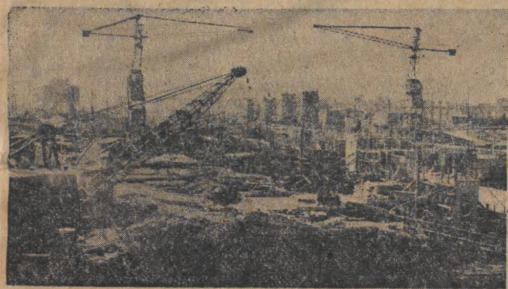
W Nowej Hucie rozpoczęto budowę wielkiego obiektu — walcowni blachy. Wszystkie urządzenia mechaniczne, zgniatacza dostarcza Zielonek Radziecki. NA ZDJĘCIU: ogólny plan budowy fundamentów hali walcowni-zgniatacza. CAF — fot. Kondraczek
