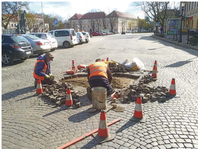
Pracownicy Zakładu Utrzymania Miasta naprawiali w poniedziałek 26 kwietnia nawierzchnię na Starym Rynku.
