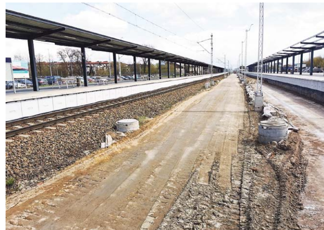
Peron nr 2 dworca Łowicz Główny jest na razie wyłączony z ruchu, przygotowywane jest dopiero podłoże do położenia torów.
