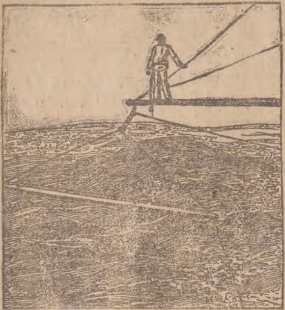
Robotnik przy pracach reperacyjnych.
