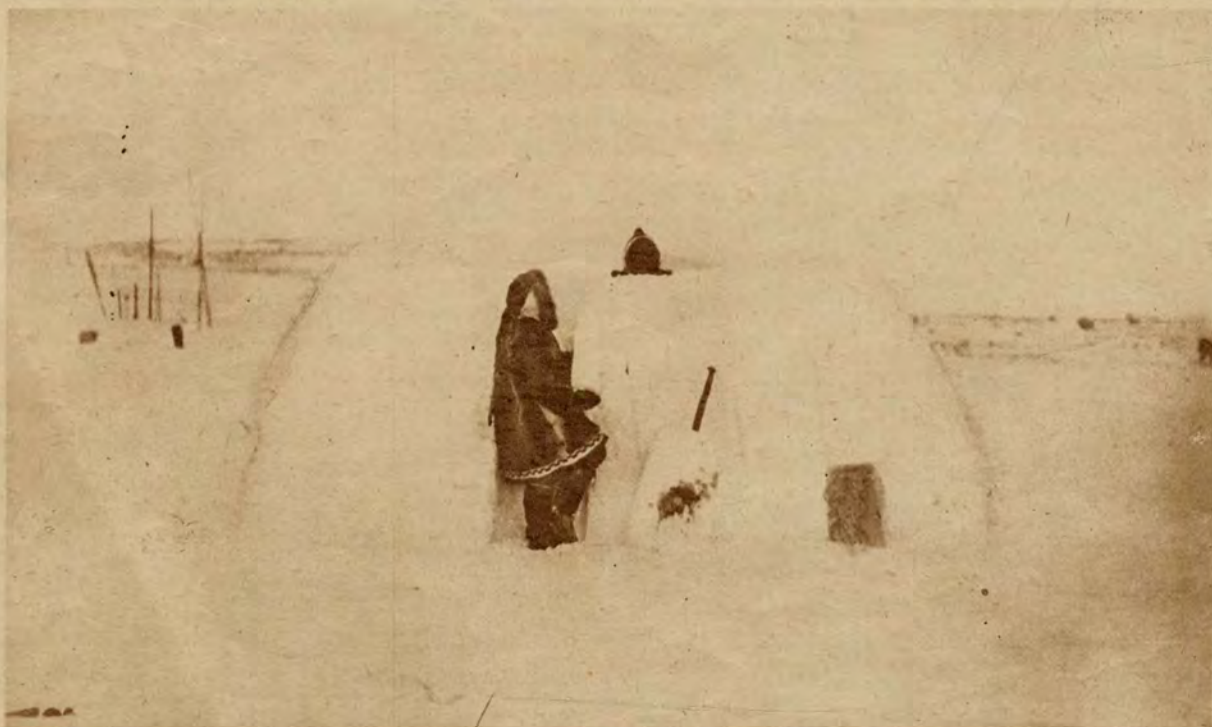
Eskimosi w Grenlandji budują sobie na zimę chatki z grubych płyt lodowych. Zamiast drzwi są tam tylko 2 otwory, jeden większy dla mieszkańców, a drugi mniejszy zastępujący komin. Okrągłe te chatki odznaczają się wielką ciepłotą.
