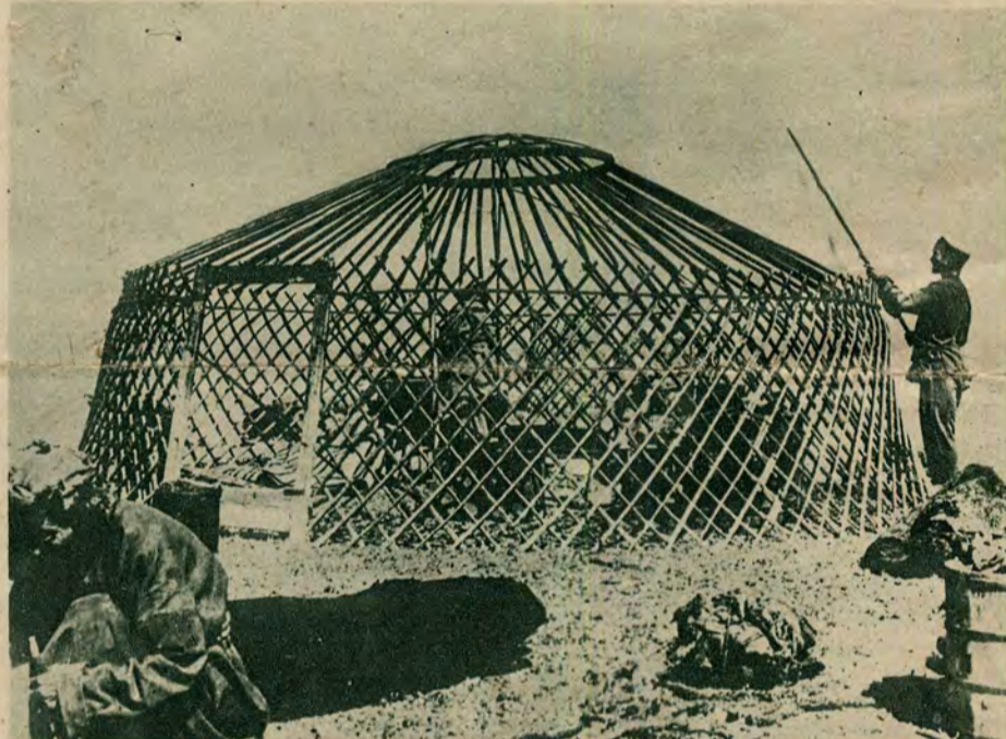
Ta sama wyprawa zapoznała się w Mongolji z całym szeregiem szczegółów życia mieszkańców tego mało znanego kraju. Zdjęcie przedstawia drewniane rusztowanie „jurty“ czyli domu mieszkalnego. Rusztowanie to pokrywa się wołjokiem i mieszkanie gotowe.
