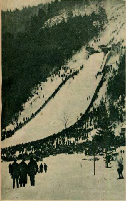
W Zakopanem, na północnych stokach regli, zbudowano po dwuletniej pracy wielką skocznię narciarską, nie ustępującą rozmiarami zagranicznemu tego rodzaju urządzeniu. Zdjęcie przedstawia ogólny widok skoczni „na Krowki”.
