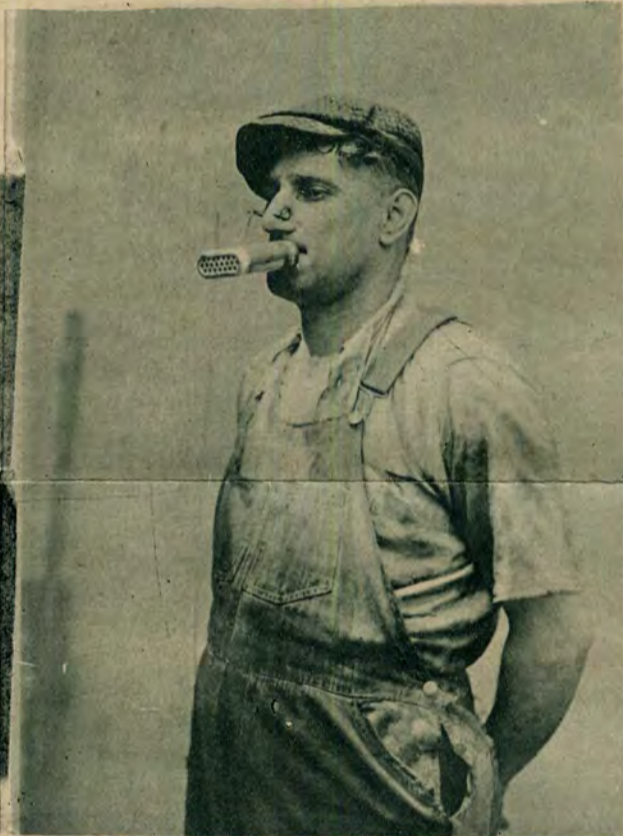
Amerykańskie ministerstwo kolei żelaznych zaopatrzyło robotników, pracujących w głębokich tunelach częstokroć w trującej atmosferze, w kieszonkowe maski gazowe. Oddają one te same usługi, co duże maski a są znacznie wygodniejsze.
