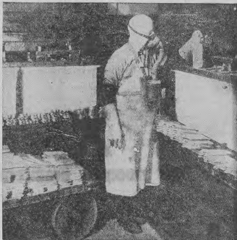
robotnicy pracują w maskach, które ich chronią przed niebezpieczeństwem zatrucia gazami.
