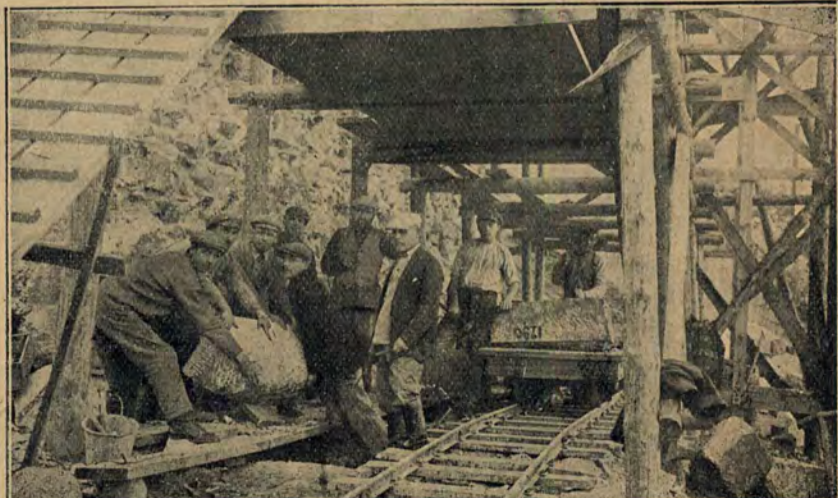
Układanie pierwszej warstwy przyczółka nadbrzeżnego.
