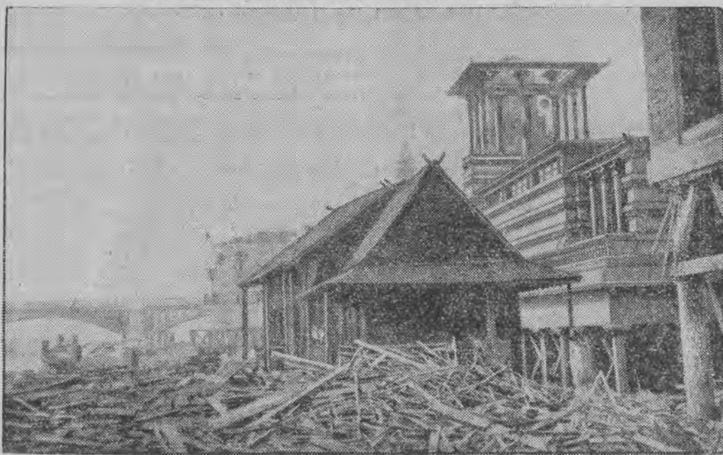
przystąpiono natychmiast do rozbiórki niektórych pawilonów na brzegu Sekwany.
