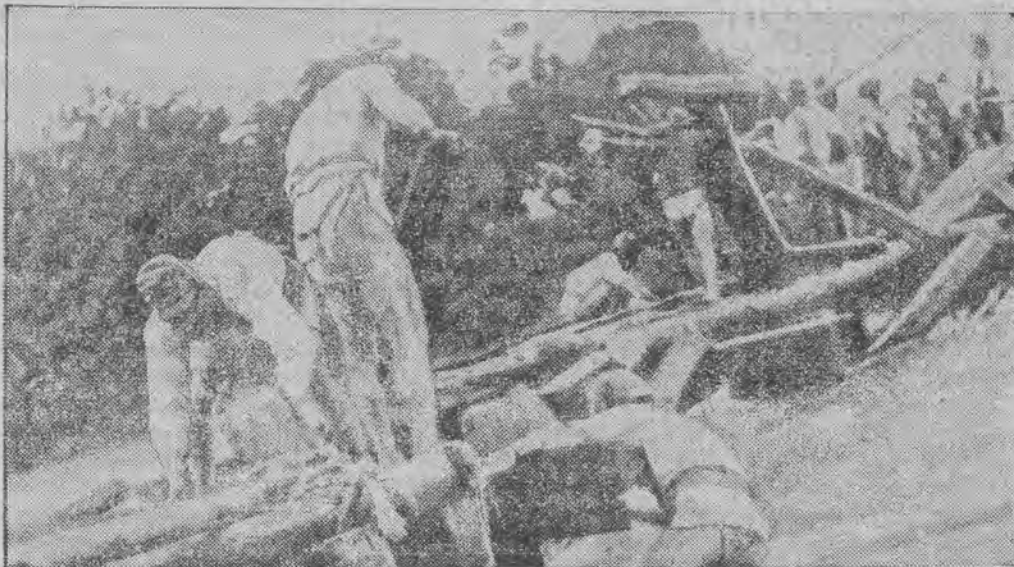
Żołnierze naprawiają most zniszczony wskutek powodzi, jaka miała miejsce w Chinach w związku z wylewem Żółtej rzeki (Hoangho).
