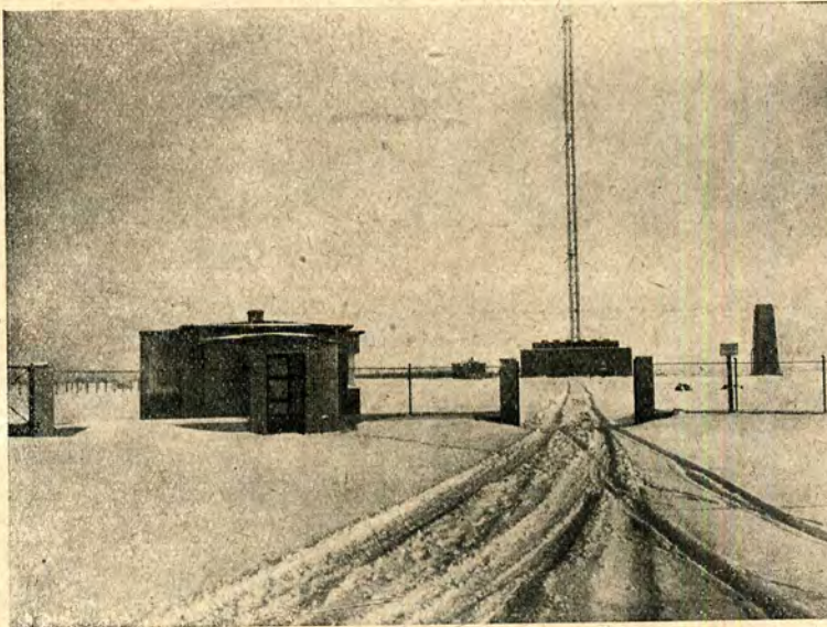
Główny wjazd do stacji nadawczej w Raszynie.
