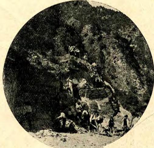
Budowa tunelu w górach alpejskich.
