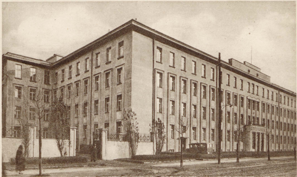
ŁÓDZ. Szpital Ubezpieczalni Społecznej
