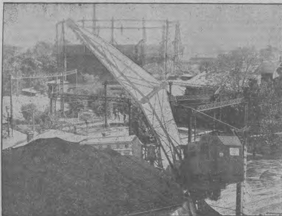
Imponująco przedstawia się ogólny widok terenów gazowni miejskiej w Łodzi. Na zdjęciu — gazownia miejska. Na pierwszym planie żóraw parowy, dowożący węgiel do piecowni.
