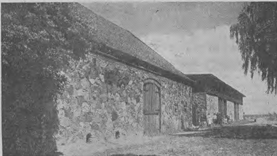
Gumna majątności na Mazurach, wykonane całkowicie z kamienia.
