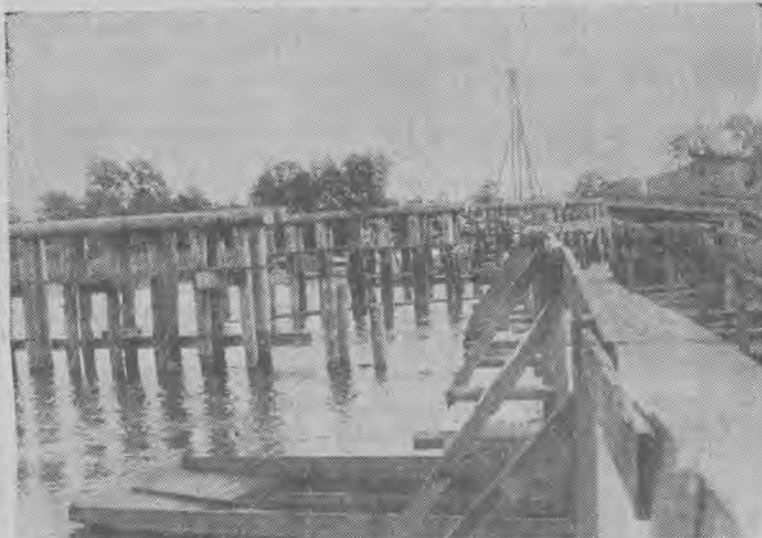
Fragm. budowy mostu na Pilicy pod Opocznem.
