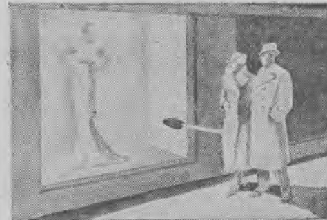
Przerwanie barjer świetlnych powoduje zapalenie światła w oknie wystawowym, które ściga na siebie uwagę przechodniów.
