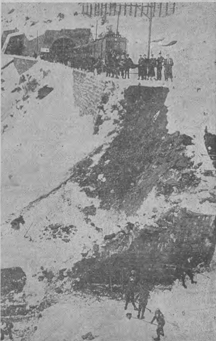
W Szwajcarii lawina zerwała most i część tamy kolejowej na szlaku Brig — Kandersteg.
