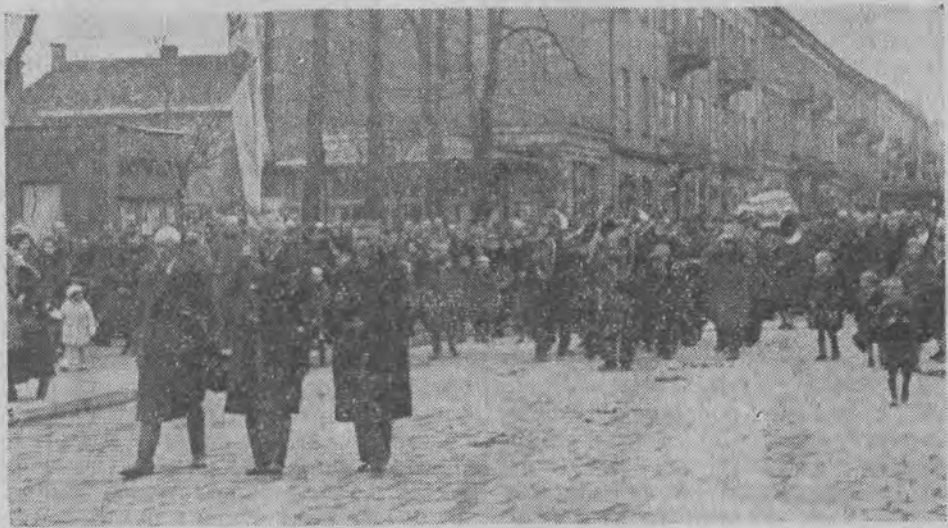
Fragment z pogrzebu jednej z ofiar katastrofy kolejowej pod Rudnikami. Kondukt żałobny ze zwłokami kolejarza śp. Ostromeckiego na ulicach Piotrkowa, gdzie śp. Zmarły mieszkał.
